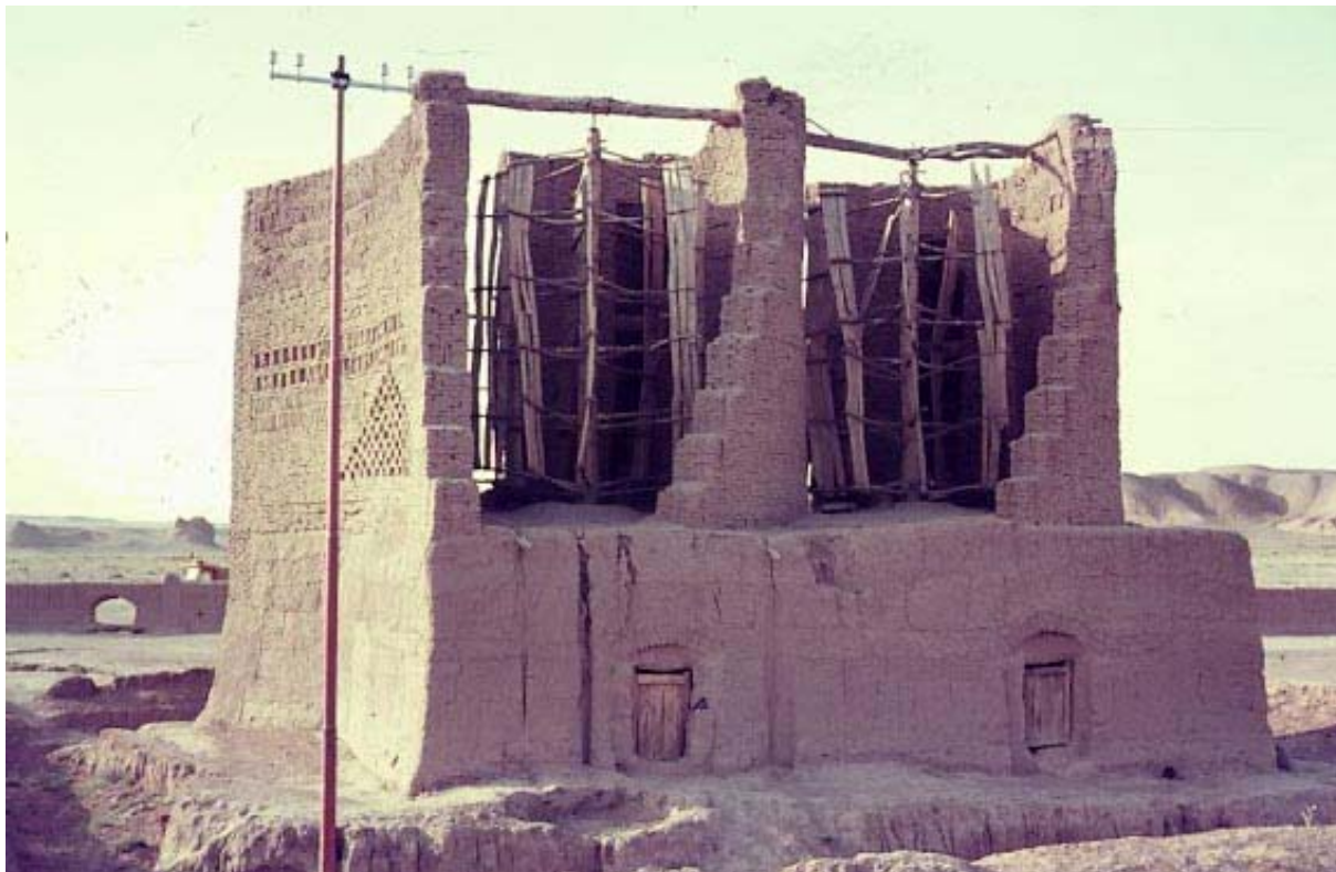
Väderkvarn längs vägen. Konstruktionen fungerar, eftersom det nästan alltid blåser från samma håll.
